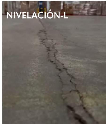
Un desnivel de tamaño medio (diferencia de altura 5-9mm) en las juntas de construcción o en las puertas de paso que conectan 2 naves perjudica a los vehículos industriales y hace que la conducción de los mismos sea peligrosa ya que estos pueden empezar a balancearse al circular a cierta velocidad.
