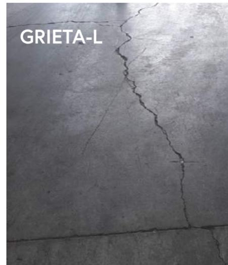
**Fisura de tamaño medio (2-9mm)** que puede ser recta, curva o en zigzag. Es necesario repararla ya que el desmoronamiento existente provocará un desprendimiento de las piezas de hormigón dentro de la fisura. La consecuencia será un daño importante de la superficie.
