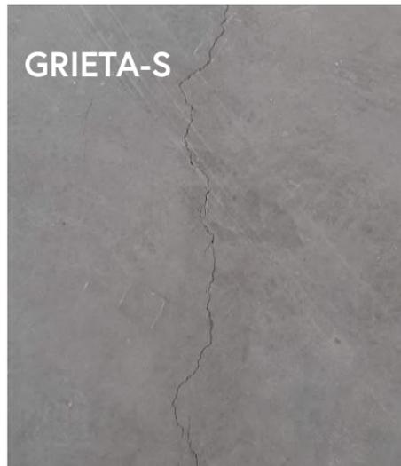
**Fisura menor (<2mm)** que puede ser recta, curva o en zigzag. Es necesario repararla para evitar el desmoronamiento, que generalmente convierte una fisura en S en una fisura en L.
