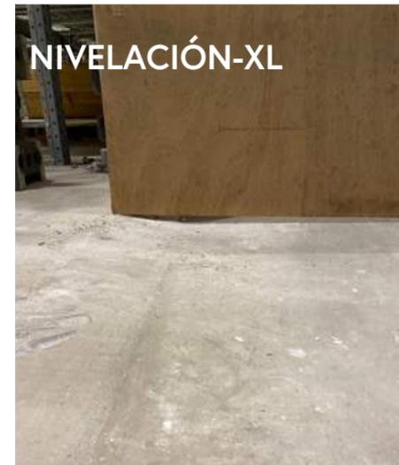
Un desnivel severo (diferencia de altura > 10mm) provoca grandes grietas e importantes daños en la superficie debido al impacto de los vehículos industriales contra el borde de hormigón en la zona desnivelada. Además, causan daño a los vehículos de ruidas rígidas lo que conveva elevados costes de mantenimiento.
