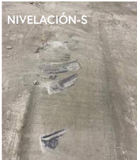
Un pequeño desnivel (diferencia de altura < 5mm) en las juntas de construcción o en las puertas de paso que conectan 2 naves perjudica a los vehículos industriales y hace incómoda la conducción de los mismos.
