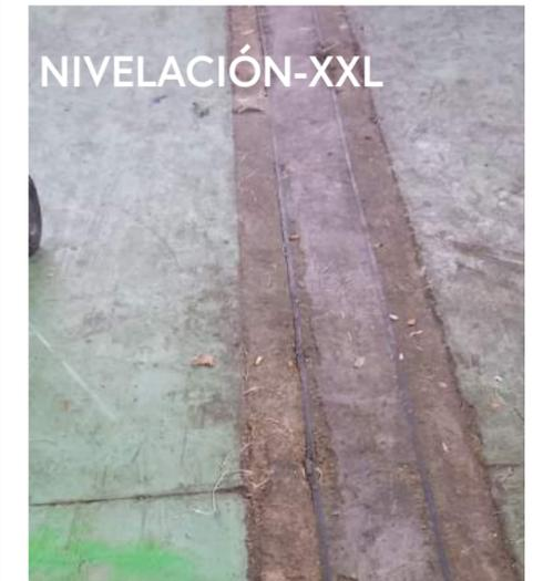
Desniveles muy fuertes que en algunos casos hacen imposible el acceso a la zona contraria. Los trabajos de reparación pueden consistir, en el peor de los casos, en cortar y reconstruir partes enteras del forjado de la zona afectada.
