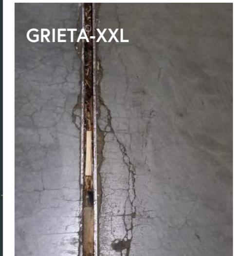
**Fisura XXL ( $\geq 30\text{mm}$ )** son consecuencia de una grieta XL que no ha sido reparada a tiempo y para evitar mayores daños en la superficie. Estas zonas son muy peligrosas ya que pueden causar accidentes graves. Las zonas con grietas XXL no deberían utilizarse en absoluto en operaciones de almacén o logística.
